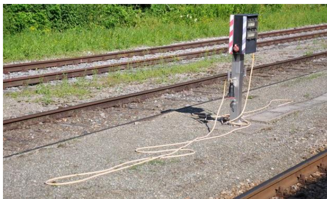
Obr. 8 Příklad temperování baterií ze sítě 3x400 V
