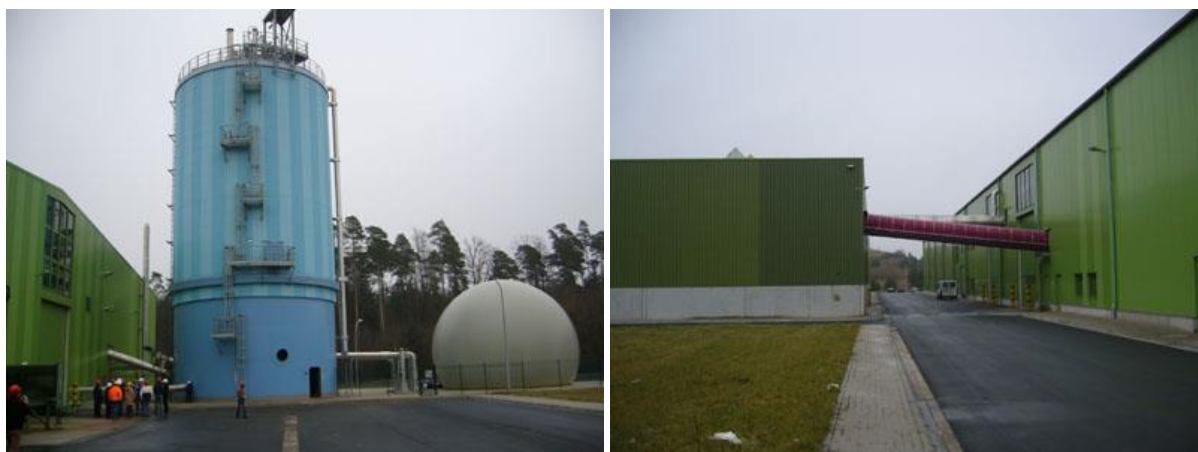
Obr. 56 Fermentor s plynojemem (vlevo) a biologická stabilizace (vpravo) (Portál MBÚ)
