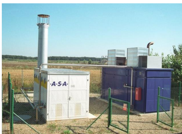
Obr. 51 Kogenerační jednotka – kontejnerové provedení
