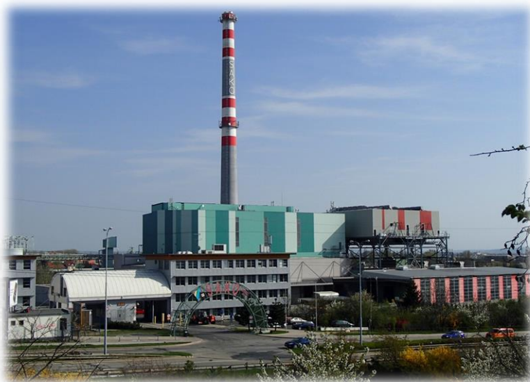
Obr. 53 Pohled na spalovnu SAKO Brno
