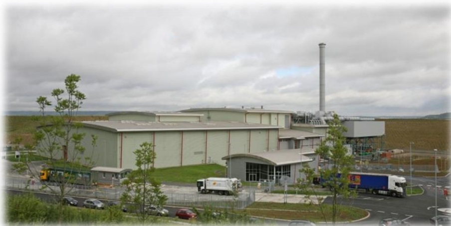
Obr. 50 Pohled na spalovnu Allington
