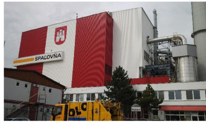
Spaľovňa komunálneho odpadu Bratislava.
