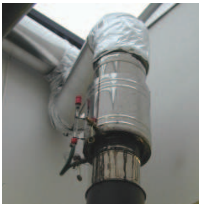
OBR. Č. 13 VODNÍ UZÁVĚR KOUŘOVODU
