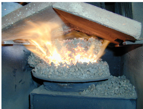
obr. č. 21 Spečenec popela na retortě kotle
