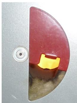
obr. č. 31 Kotel Dakon DOR32 s, přívod sekundárního spalovacího vzduchu
