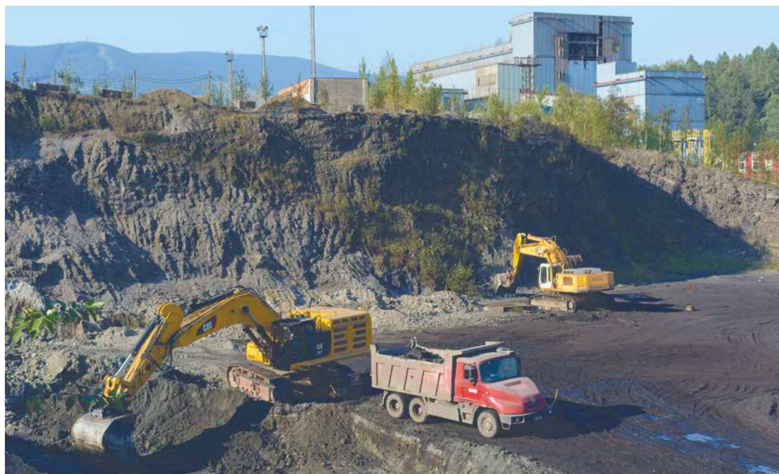
Silné moderní stroje již pracují na odtěžování haldy.
