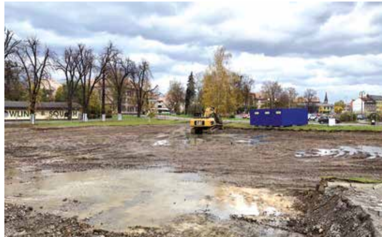
S pozemními pracemi se již začalo.
