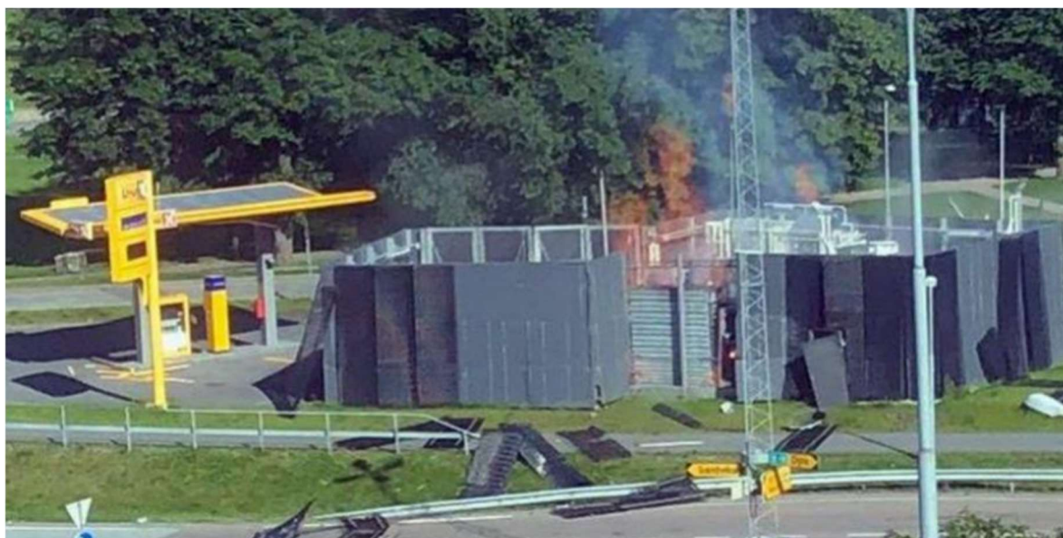
Obrázek 15: Výbuch 3-3,5 kg vodíku v roce 2019 v Norsku, na snímku je zřetelné poškození konstrukcí a rozlet kusů konstrukcí.
