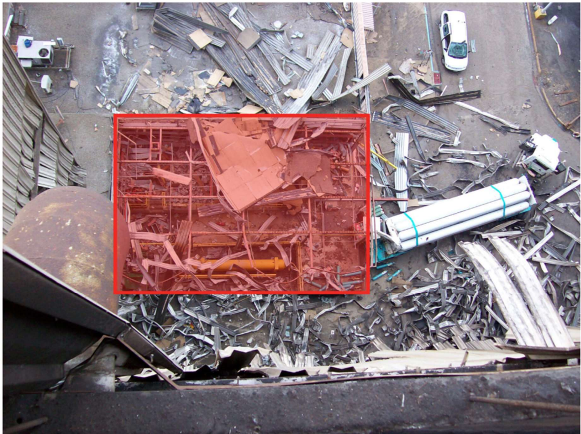
Obrázek13: Červeně označená ochranné je místo původního ochranného přístřešku, který nebyl projektován podle pravidel pro bezpečné odvětrávání, což umožnilo hromadění výbušného plynu. [27]
