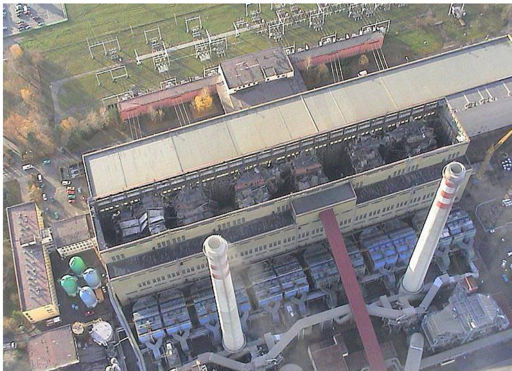
Obrázek 27: Havárie v elektrárně Opatovice
