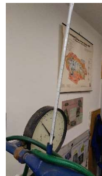
Obrázek 12 Rtuťový teploměr umístěný v teploměrové jímce
