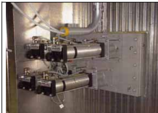
Obr. 5.56 Pneumatické oklepávání stacionárně umístěné
