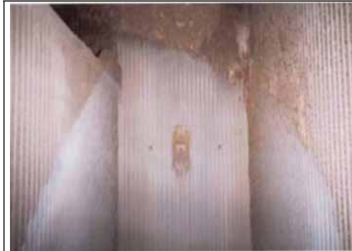
Obr. 5.62. Účinek čištění na výhřevných plochách
