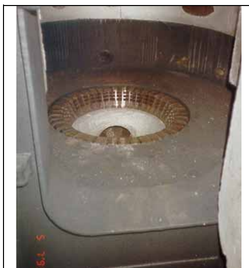
Obr. 6.18. Podsuvný rošt s kruhovou retortou konstrukce Vyncke
