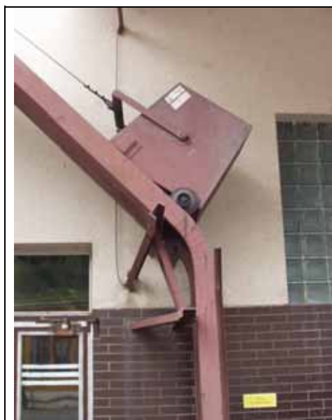
Obr. 5.15. Detail skipového výtahu
