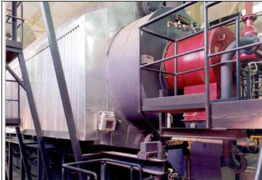
Obr. 6.2. Práškové ohniště na biomasu s hořákem
