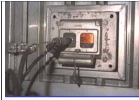
Obr. 5.49. On line injektáž aditiv do ohniště patří k preventivním metodám
